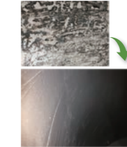
タンク内腐食補修
