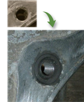
ボルトの穴補修
