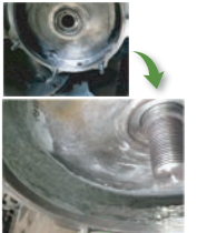
ポンプケーシング摩耗補修
