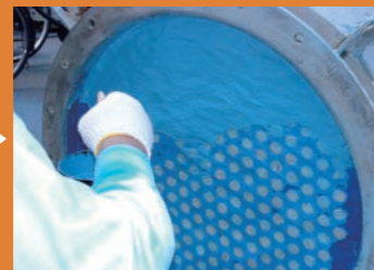
補修 ブラッシュャブルセラミックとセラミックリペアーを使用して、チューブ式熱交換器管板面の恒久的な補修ができる。
