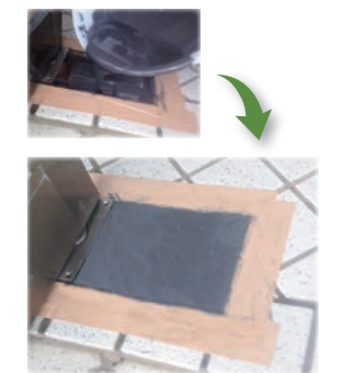
コンクリート破損部補修
